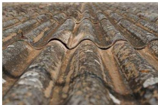
Toiture ondulée en amiante-ciment
