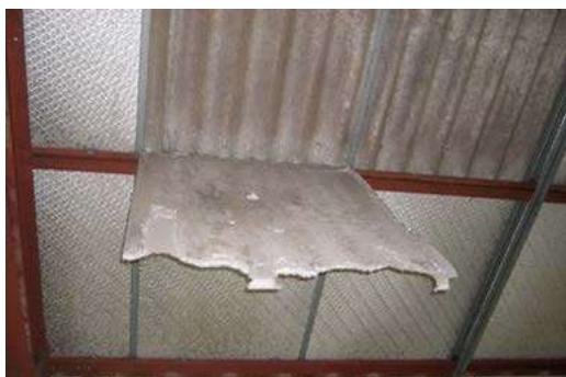
Panocell® amiante sous toiture ondulée en amianto-ciment
